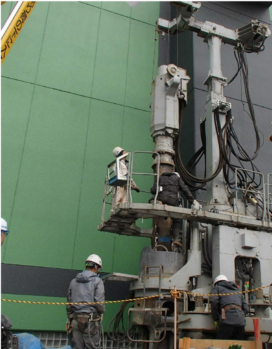
ハンドリング装置使用時の鋼矢板圧入状況
