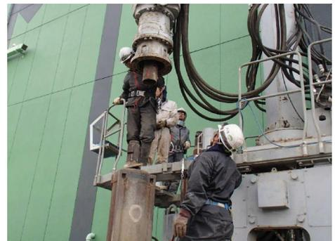
ハンドリング装置によるケーシング縦継状況
