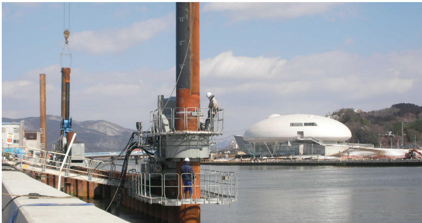
▲内海橋地区施工状況
