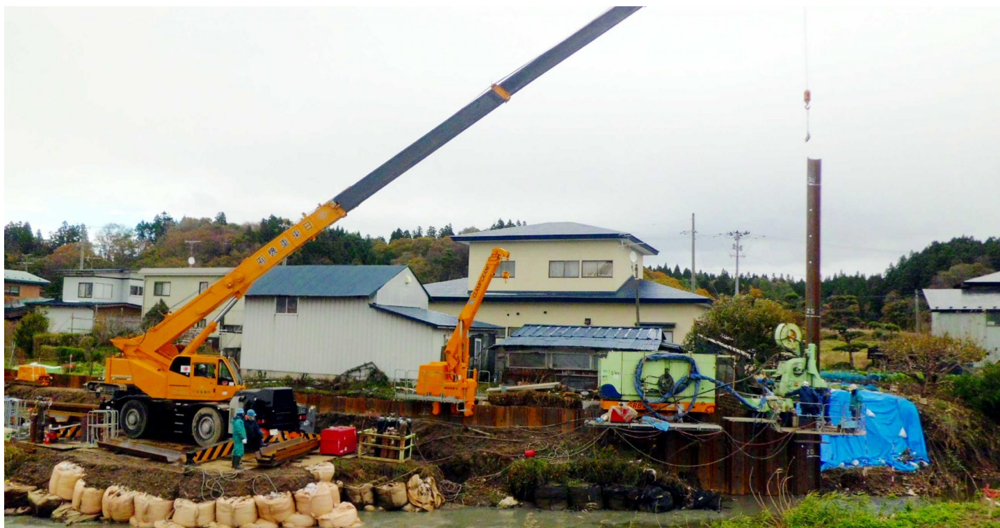
▲ノンステージング工法【NETIS登録技術：KT-000106-V】によるシステム施工
