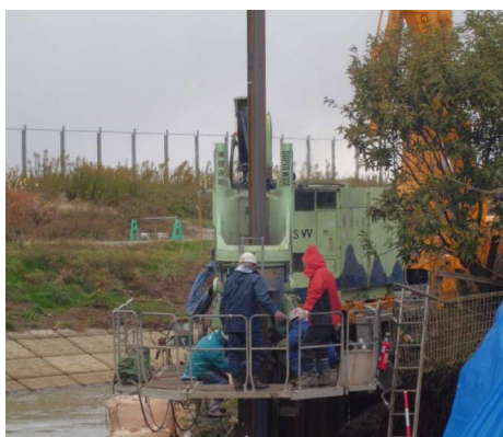
▲パイラスステージ上での圧入作業
