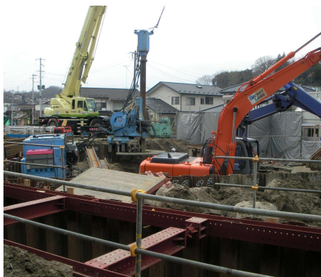
△二期施工(土留め壁施工)
