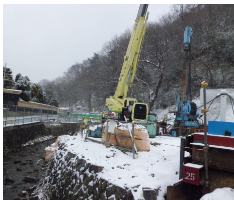
△一期施工(仮水路壁施工)
