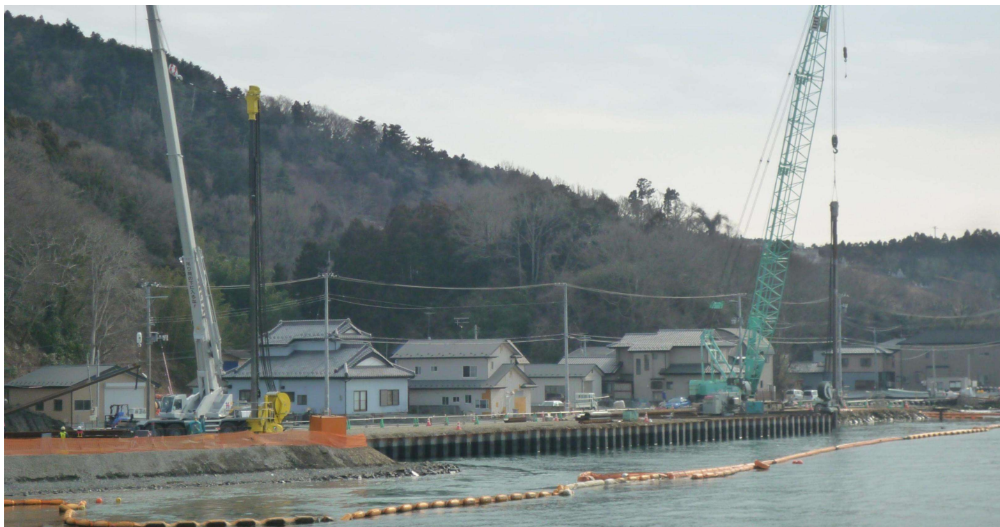
△複数台による圧入施工
