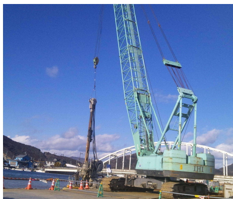
△仮設レスによる水上施工
