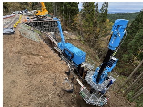
コーナー部施工状況
