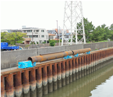
鋼管矢板 2 本同時搬送中
