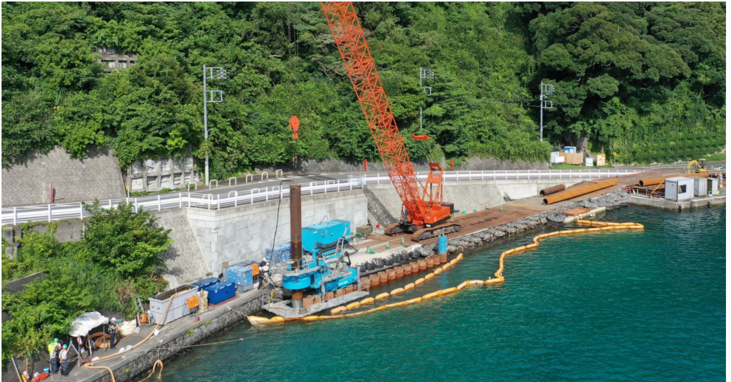
施工状況（全景）
