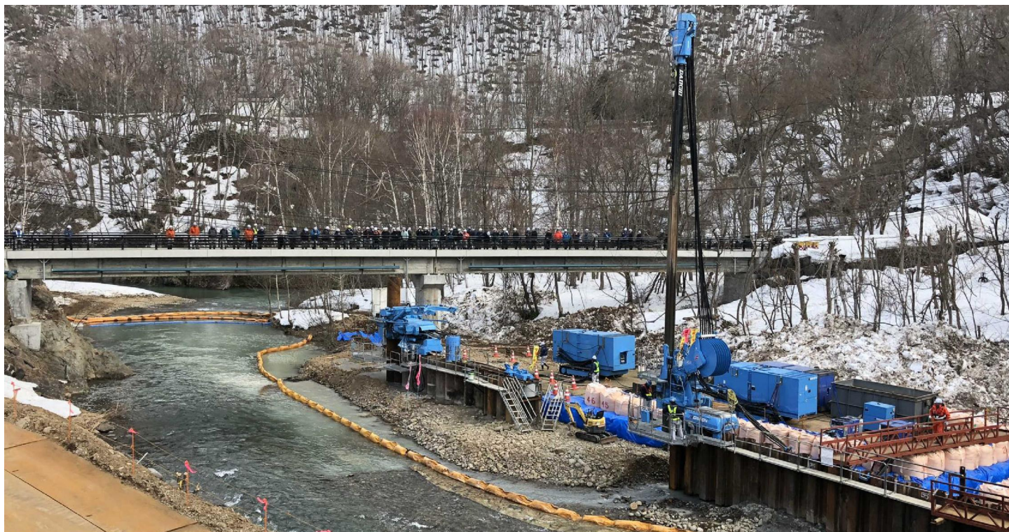
鋼管杭・鋼矢板同時施工
