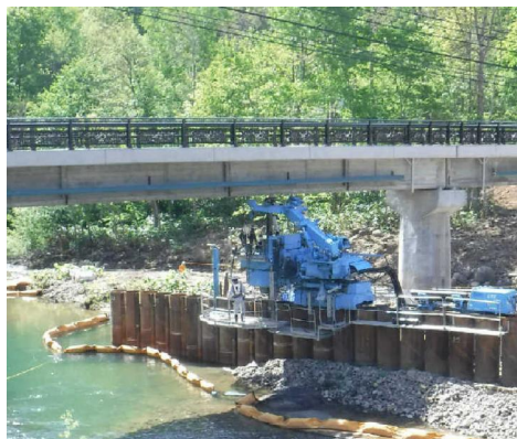
小口径鋼管圧入
