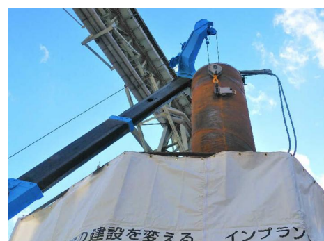
ベルトコンベア下での建込み
