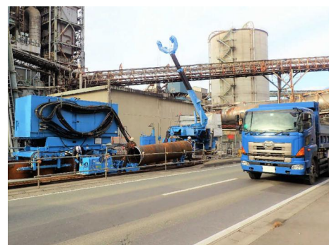
隣接する県道を供用しながら施工
