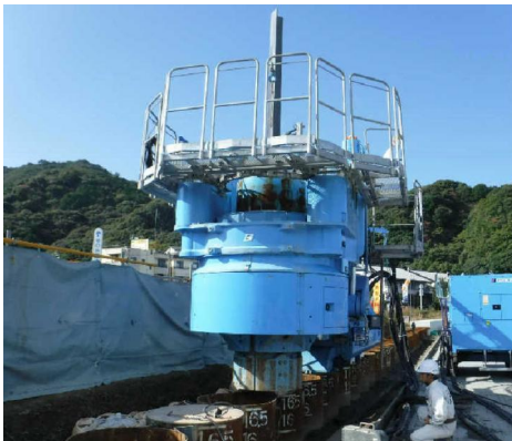
継手部材圧入
