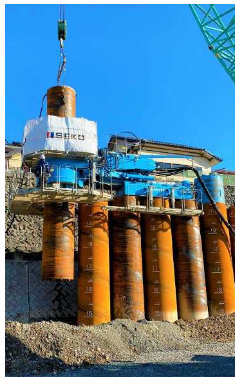
▲鋼管杭建込み
