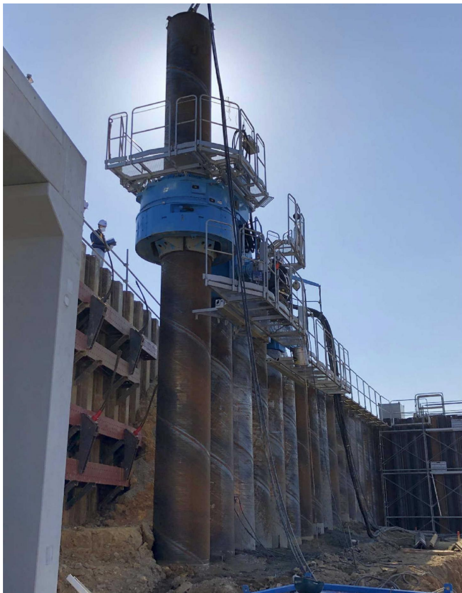
新設構造物との近接施工
