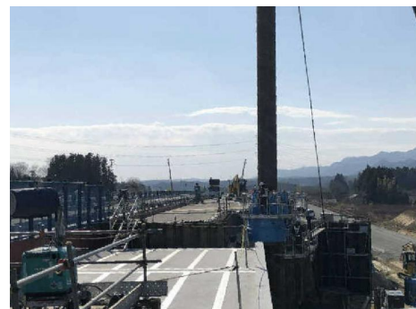
供用道路に近接しての施工
