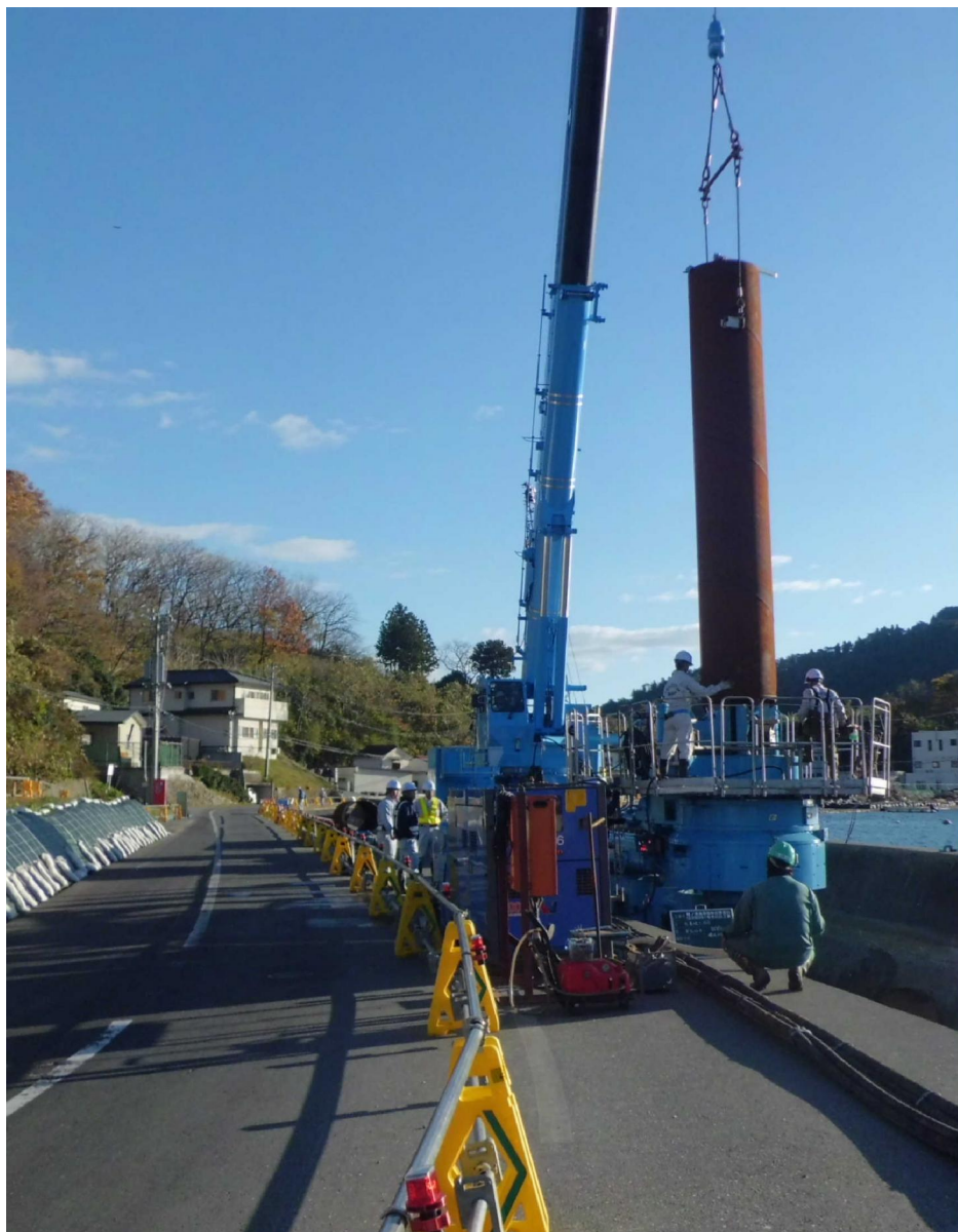
道路片側規制での施工
