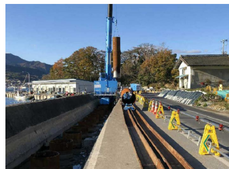
パイルランナーで鋼管杭を搬送
