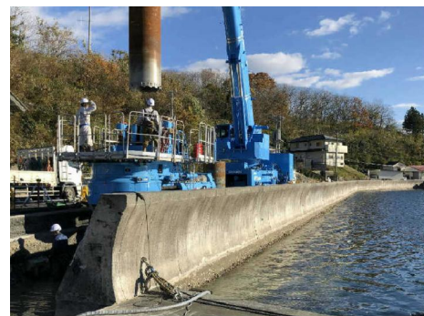
既設防潮堤の背面に圧入
