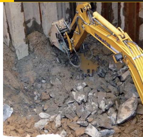
▲ 圧入後は岩盤をブレードで削りながら施工
