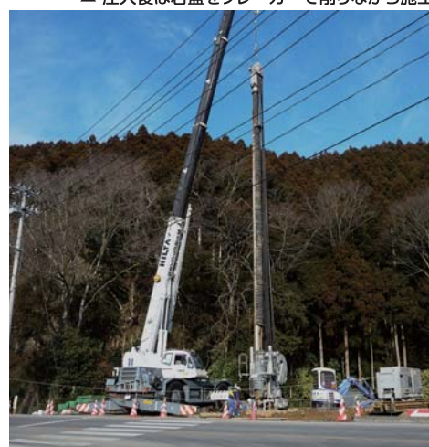
▲ 圧入後は岩盤をブレードで削りながら施工
