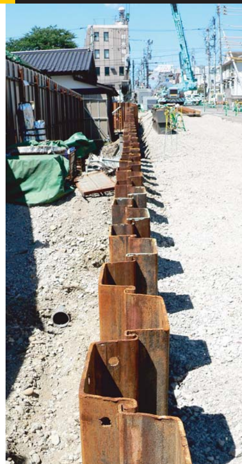
▲ 硬質地盤への高い施工精度
