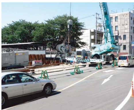
▲ 圧入機の優位性を生かした狭隘地での施工
