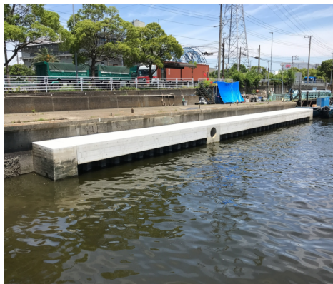
護岸完成状況
