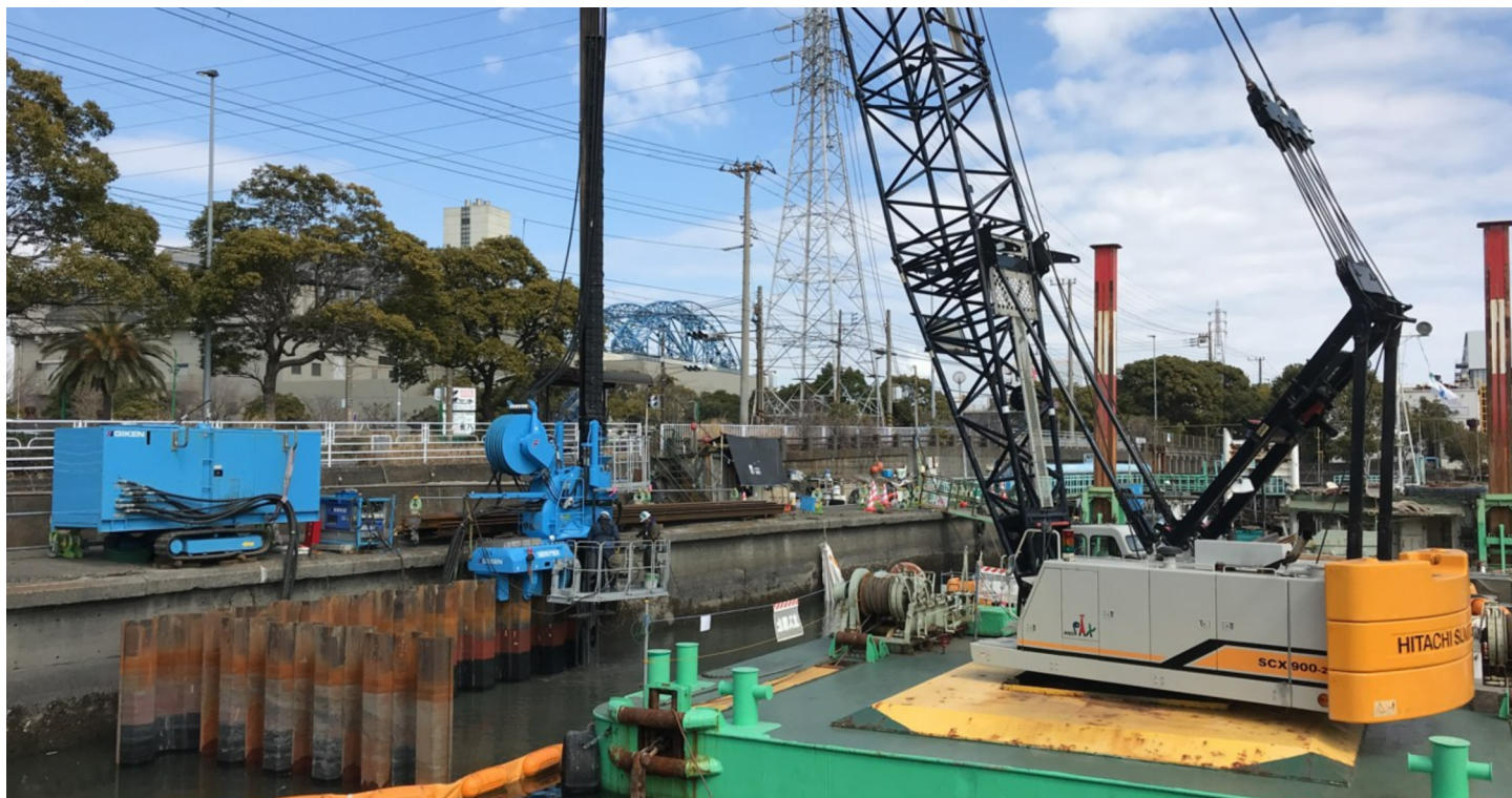
鋼矢板圧入状況
