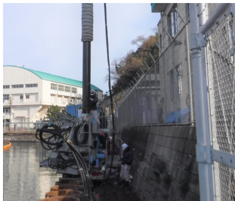
小口径管圧入状況
