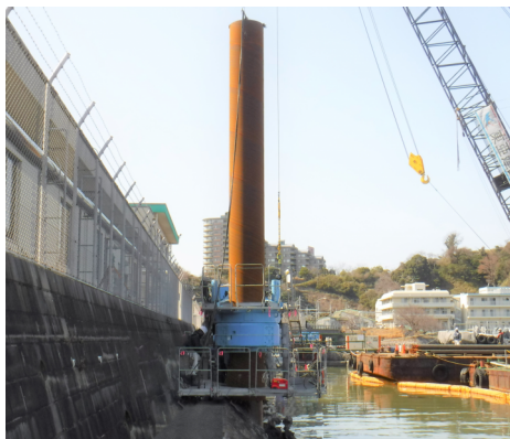
鋼管杭圧入状況
