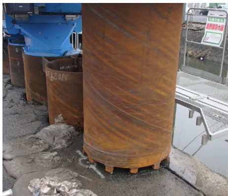
既存護岸部圧入
