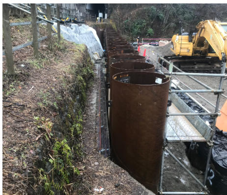
圧入完成状況
