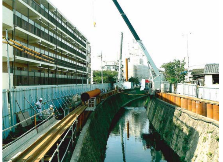
▼住宅密集地でのGRBシステム回転圧入施工
